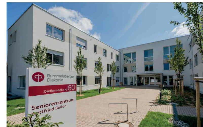
Das Seniorenzentrum Gottfried Seiler in Feucht wurde im April 2021 eröffnet. Neben einem stationären Pflegeheim bietet es eine Senioren-Tagespflege und Senioren-Wohnungen an. FOTO: Simon Malik
